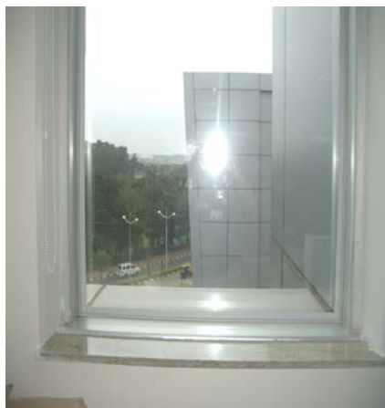
Gullwing asennettuna valmiiseen ikkunaan
